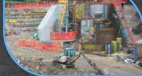
Gradbišče MHE Borovlje
